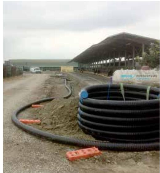
**Scavi stretti e poco profondi agevolano e velocizzano la posa della condotta CALPEX PK. A lavori finiti la tubazione trasporterà il calore prodotto dal cogeneratore alimentato a biogas**
